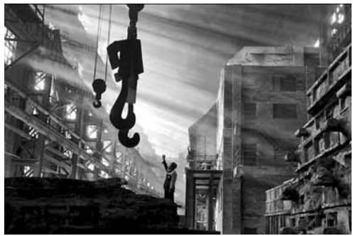
■瀋陽老工業：一位工人正在指揮吊車作業。
