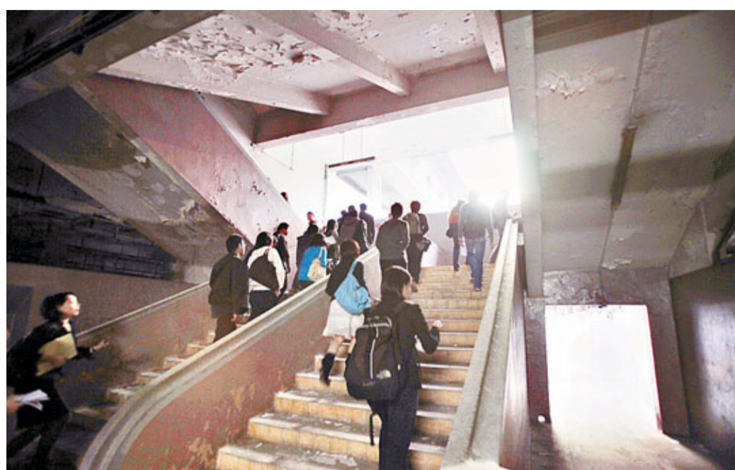
■勘察報告指出，中環街市石屎老化，不能保護鋼筋，承托力嚴重不足應付修建天台花園。圖為中環街市內部情況。
