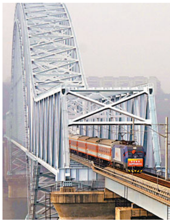
中國建設難度最高的山區鐵路宜萬鐵路昨日正式通車。鐵路通車後，川渝鄂地區出行至武漢、南京、上海的時間將縮短到5至9小時。新華社
