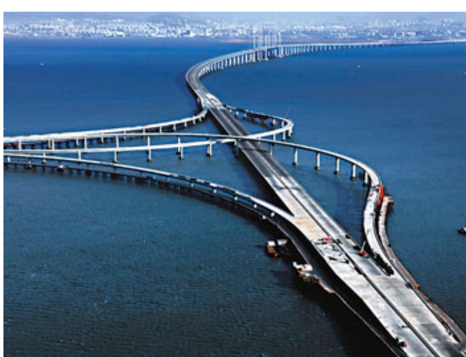
青島海灣大橋主線合龍貫通。圖為12月8日航拍的建設中的大橋。新華社
