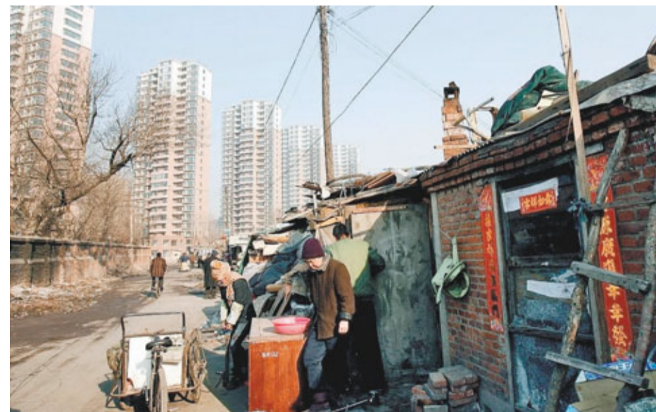
彭建國指,現在中國基尼系數接近0.5,在比較嚴重的水平,貧富差距開始令人關注。圖為瀋陽一新住宅小區與舊區遙相對望。資料圖片
