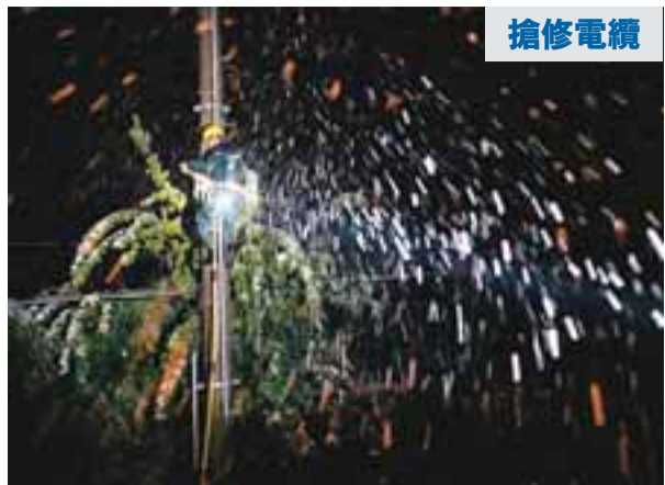
合肥市的電工冒著大雪搶修供電線路。新華社
