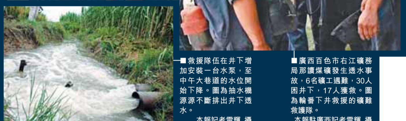
■救護隊伍在井下增加安裝一台水泵，至中午大巷道的水位開始下降。圖為抽水機源源不斷排出井下透水。 本報記者雷輝攝
