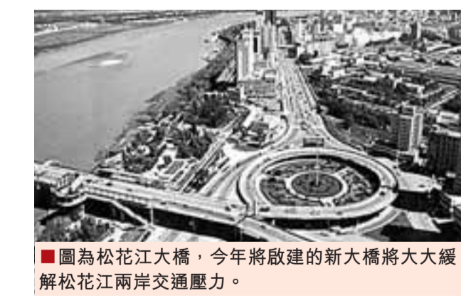
圖為松花江大橋，今年將啟建的新大橋將大大緩解松花江兩岸交通壓力。
