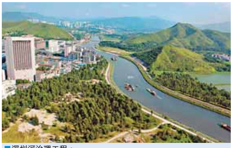
深圳河治理工程。
